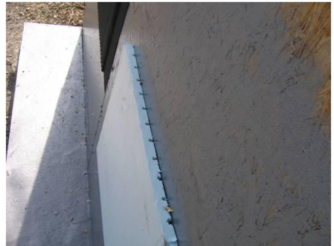
Panneau de drainage installé
